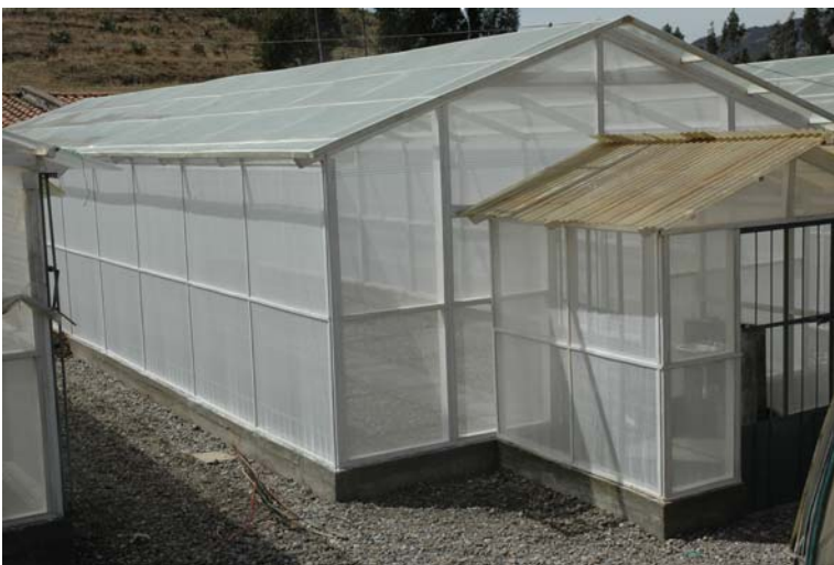
Fig. 9. Invernadero terminado, con techo de plástico y ante cámara
