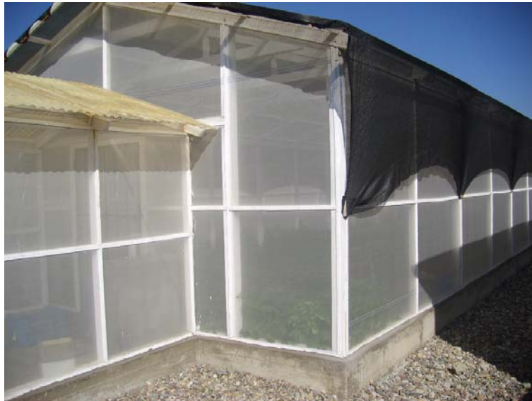
Fig. 10. Malla sombreadora (50%) cubriendo el techo de plástico. Además de dar sombra, la malla también protege al techo de vientos fuertes.
