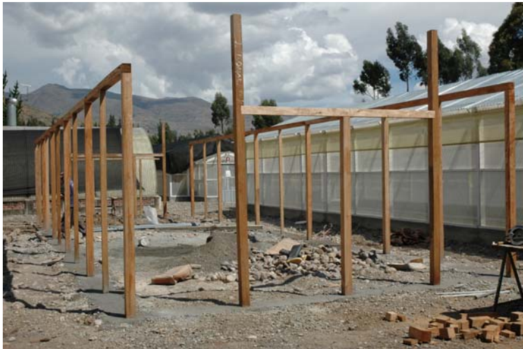
Fig. 7. Distribución de las columnas de madera ancladas en el cemento en un invernadero de 15 x 5 m.
