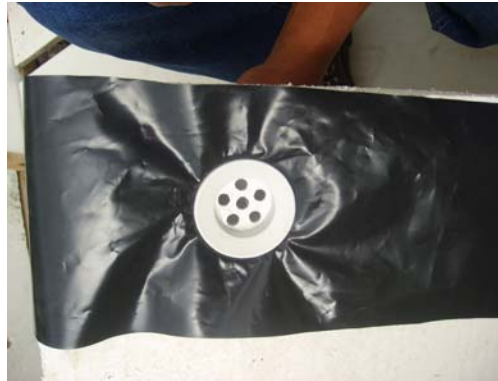
Fig.27.Detalle del sumidero de desagüe
