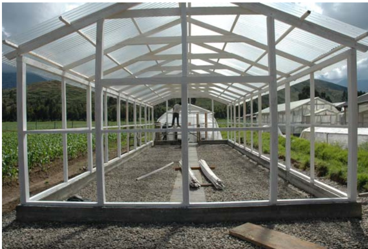
Fig. 8. El mismo invernadero con sobre cemento y techo de policarbonato.
